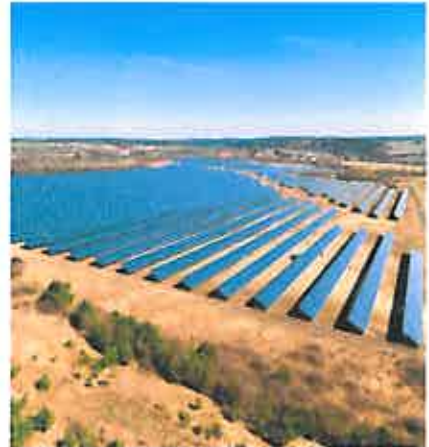
S.A.G. Solarstrom – Solarfeld Stribo, Tschechien
